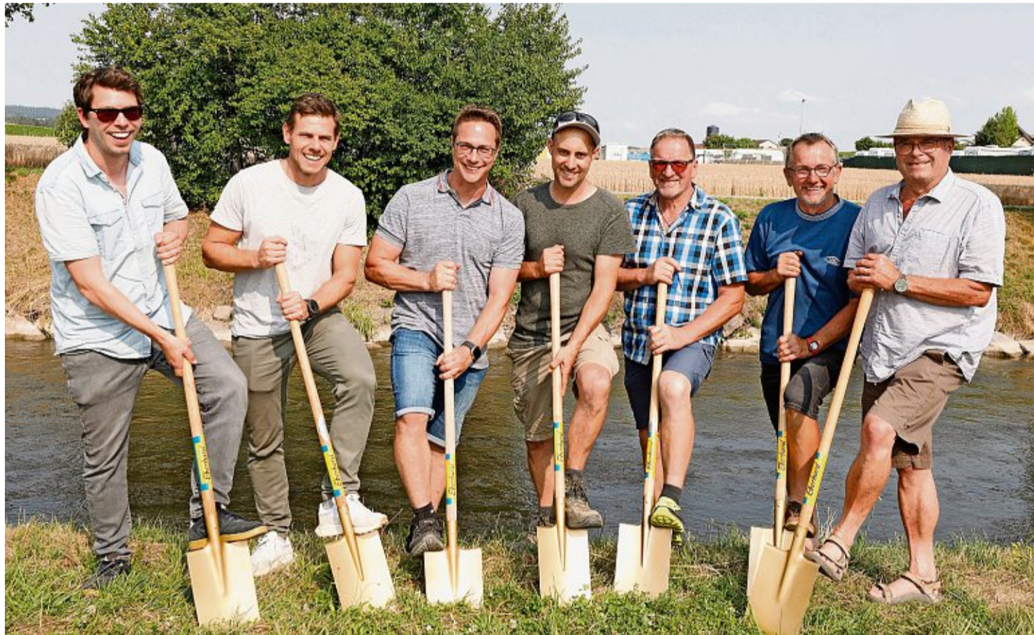
Der Vorstand der Aquapool Genossenschaft Steinmaur hat zusammen mit Unternehmern den offiziellen Baustart gefeiert. Foto: Sibylle Meier
